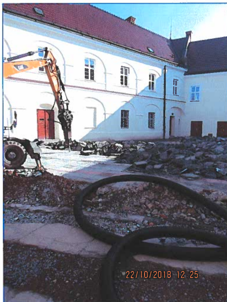
Postup prací při výměně dlažby na 1. nádvoří
