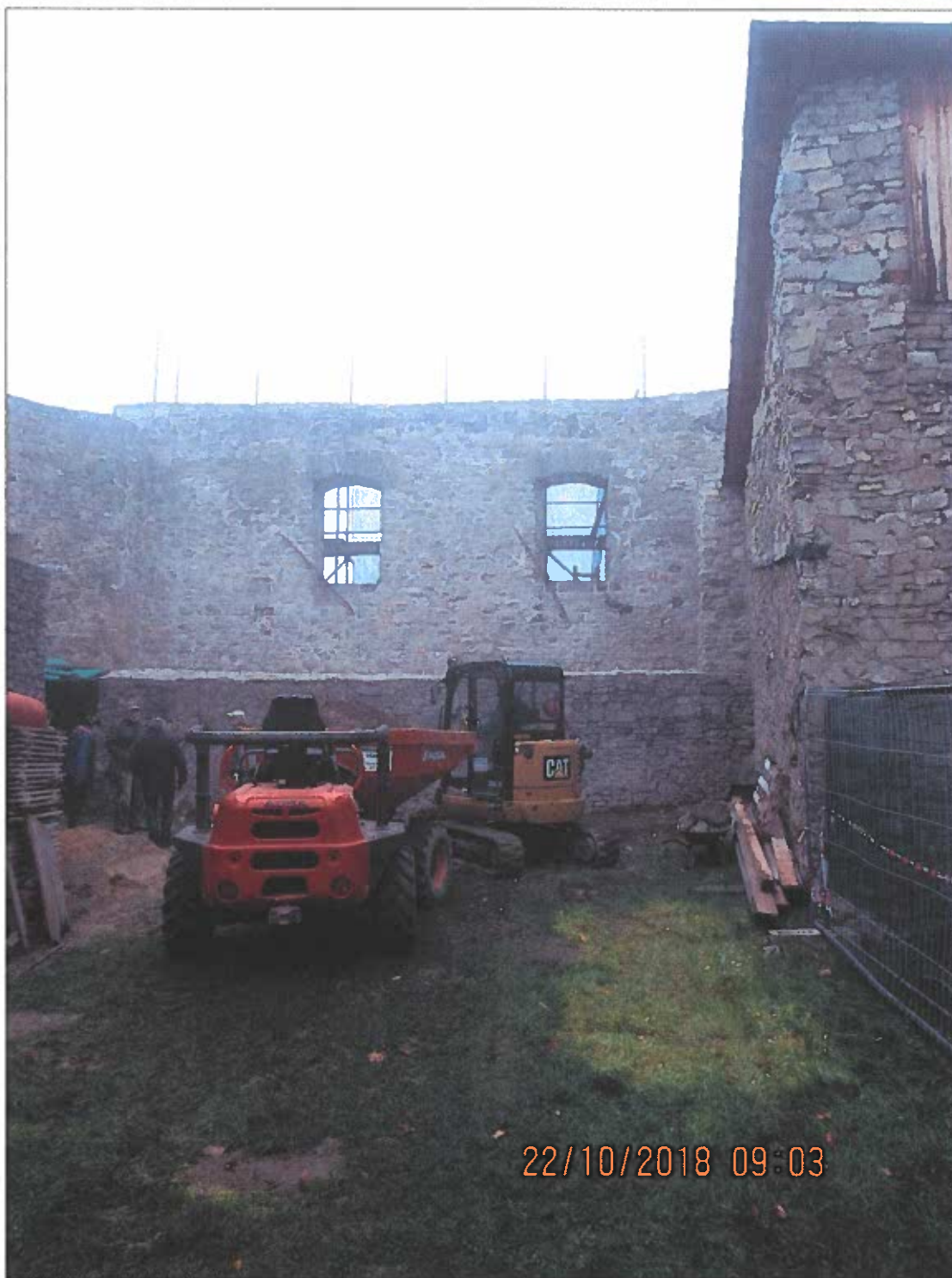
Dokončovací práce na akci „Hrad Hukvaldy – stabilizace zdi u 5. hradní brány hradu Hukvaldy“
